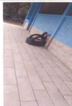
Foto 2: Sustitución de piso en corredor y socalo
