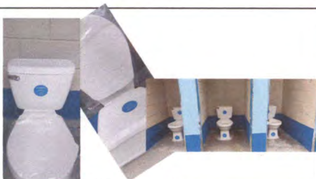
Foto 5: sustitución de servicios sanitarios
