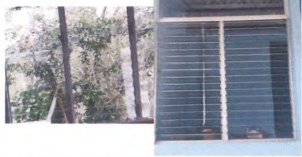
Foto 8: Sustitución de ventanas por PVC
