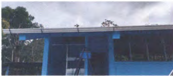
foto 9: sustitución de canal de agua pluvial.
