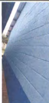
Foto 3: Pintura en muro exterior
