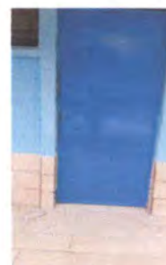
foto 6: sustitución de puerta de salón
