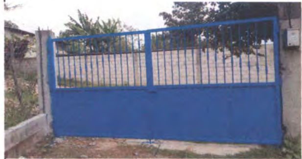
Foto 10: Sustitución de portón
