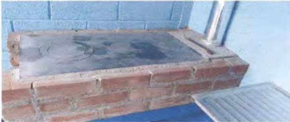
Foto 7: reparación de cocina
