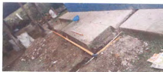
foto 12: Sustitución de tubería principal de agua potable y Sustitución de tubería PVC línea principal aguas negras
