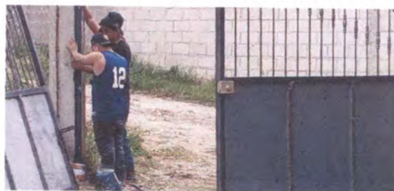
Foto 10: Sustitución de portón
