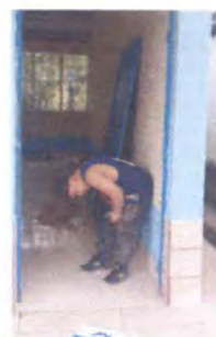
foto 6: sustitución de puerta de salón
