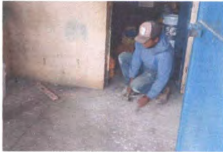
Foto1: sustitución de piso cocina
