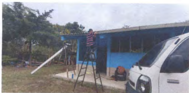
foto 9: sustitución de canal de agua pluvial.
