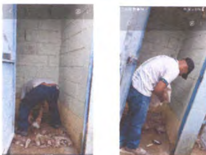
Foto 5: sustitución de servicios sanitarios
