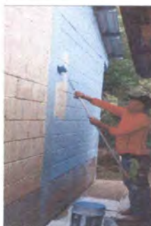
Foto 3: Pintura en muro exterior
