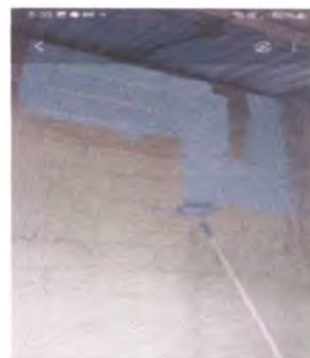
Foto 4: pintura en muro interior
