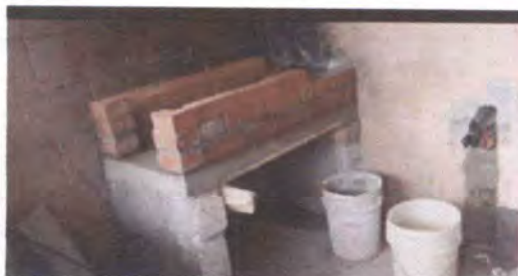
Foto 7: reparación de cocina
