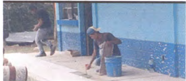
Foto 2: Sustitución de piso en corredor y socalo
