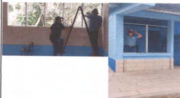
Foto 8: Sustitución de ventanas por PVC
