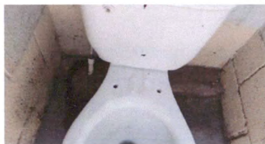
Foto 8: Sustitución de baños
