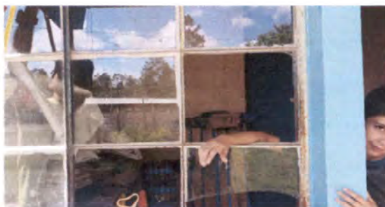
Foto 11: reparación de vidrios
