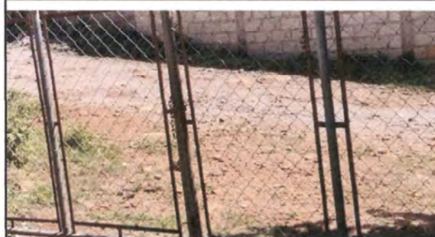
Foto 12: sustitución de portón
