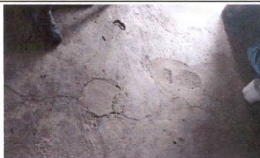
foto 6:sustitución de piso en corredor y salón 2
