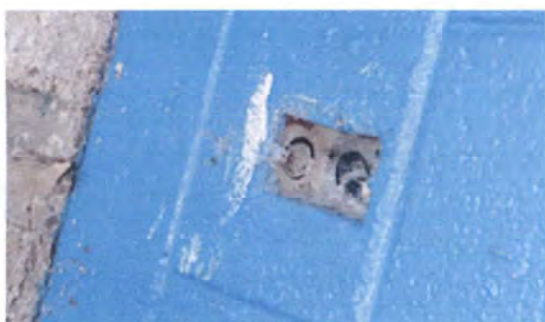
Foto 9: reparación de sistema eléctrico
