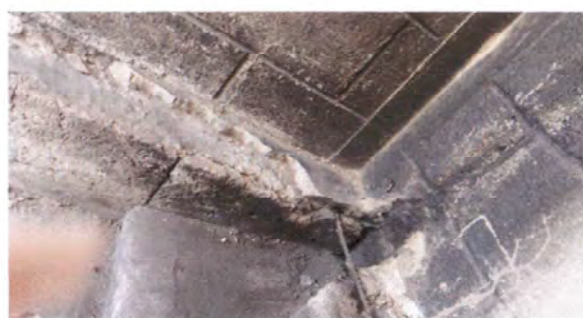
Foto 10: reparación de cocina
