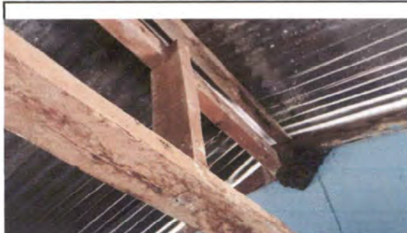
Foto 2: Sustitución de soporte de madera por metal
