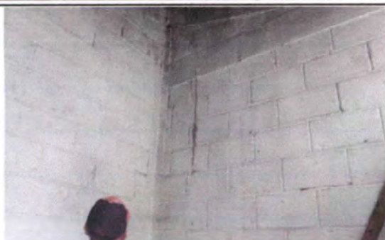
Foto 7: pintura en muros de interiores y exteriores
