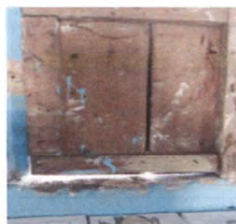
Foto 4: sustitución de ventanas
