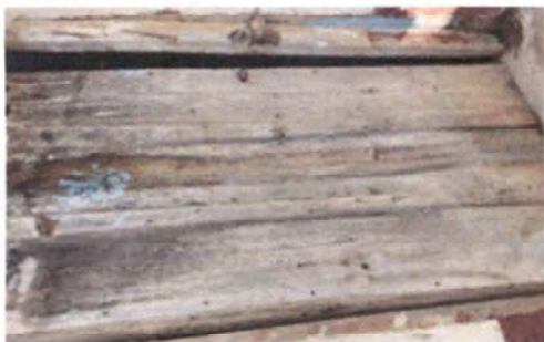
foto 3:sustitución de puertas
