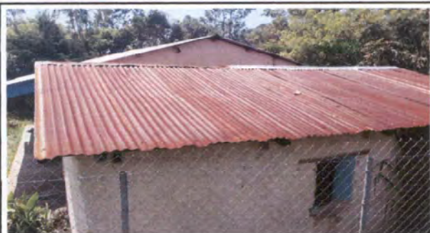
Foto1: sustitución de lámina por lámina troquelada
