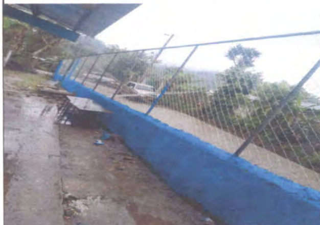
Foto 4: Continuación de Muro Perimetral
