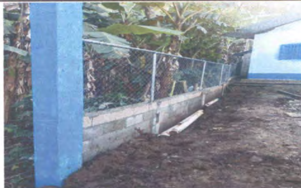
Foto 2: continuación de muro perimetral
