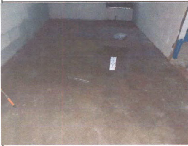
Foto 1: Cambio de piso, entortado remolineado semiliso
