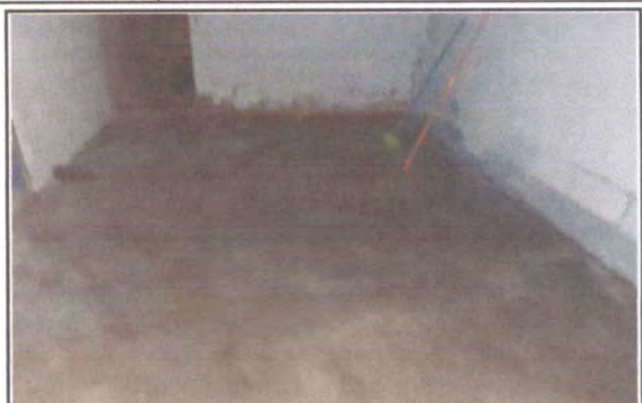
Foto 2: Cambio de piso, entortado remolineado semiliso.
