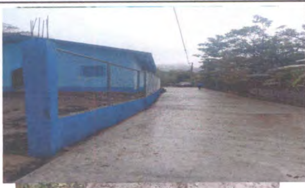
Foto 1: continuación de muro perimetral.
