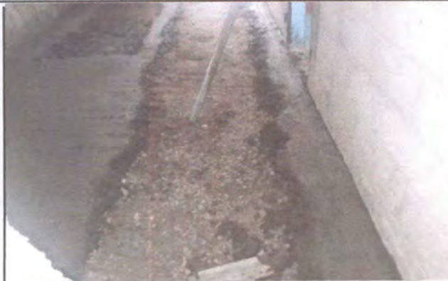
Foto 1: Cambio de piso, entortado remolineado semiliso
