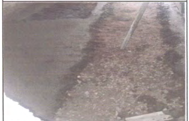
Foto 4: losa de patio
