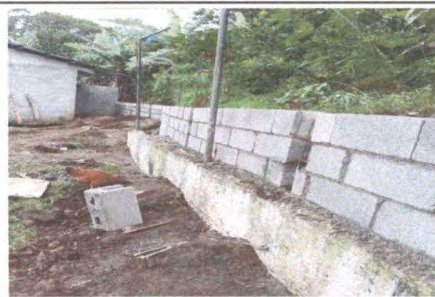
Foto 4: Continuación de Muro Perimetral
