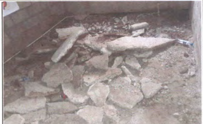
Foto 2: Cambio de piso, entortado remolineado semiliso.
