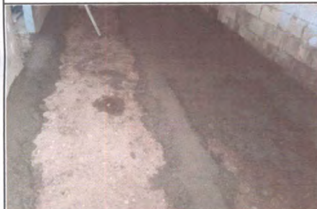
Foto 3: Cambio de piso, entortado remolineado semiliso.
