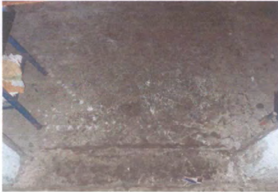
Foto 1: Cambio de piso, entortado remolineado semiliso
