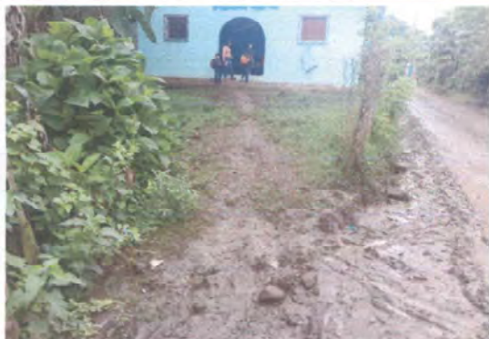
Foto 1: continuación de muro perimetral.
