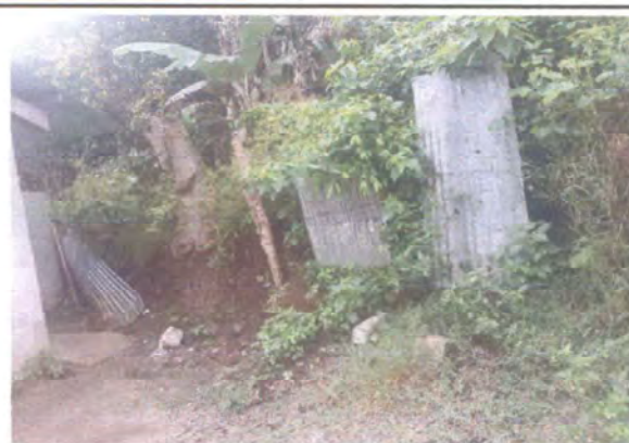
Foto 4: Continuación de Muro Perimetral
