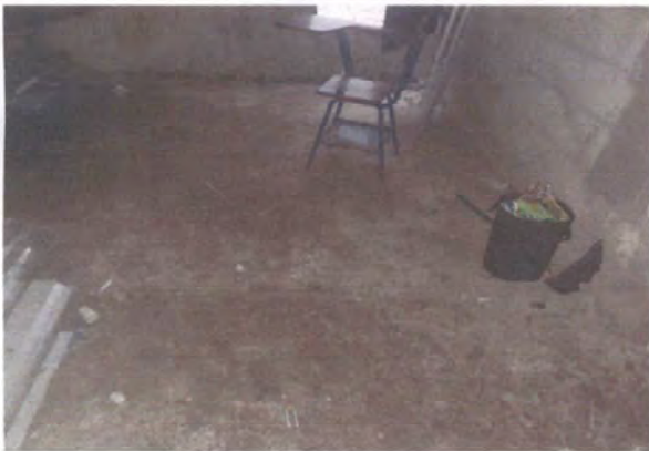
Foto 3: Cambio de piso, entortado remolineado semiliso.
