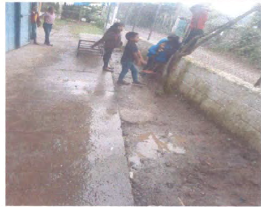
Foto 4: losa de patio
