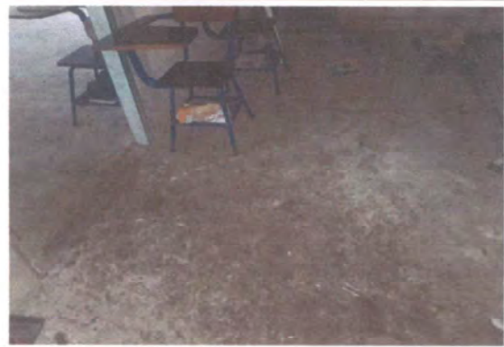
Foto 2: Cambio de piso, entortado remolineado semiliso.
