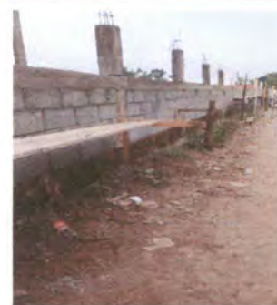
Foto 4: SUSTITUCIÓN DE MURO PERIMETRAL.
