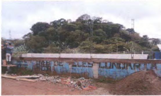
Foto 1: SUSTITUCIÓN DE MURO PERIMETRAL.
