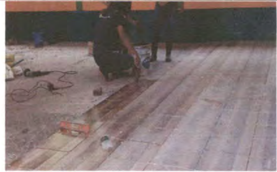
Foto 2: SUSTITUCIÓN DE PISO DE CONCRETO POR PISO CERÁMICO
