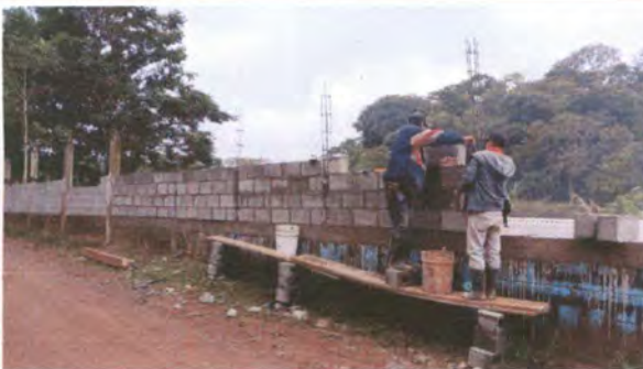
Foto 3: SUSTITUCIÓN DE MURO PERIMETRAL.
