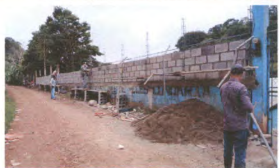
Foto 2: SUSTITUCIÓN DE MURO PERIMETRAL.
