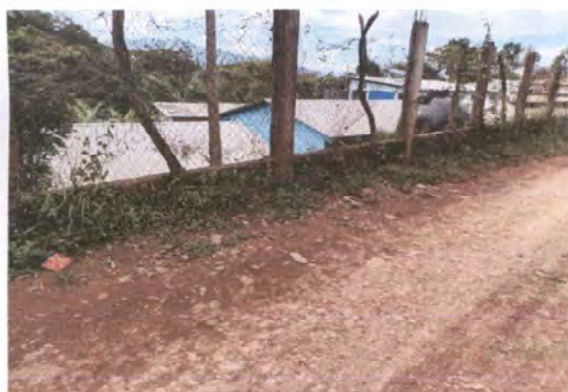
Foto 3: Completación de muro perimetral
