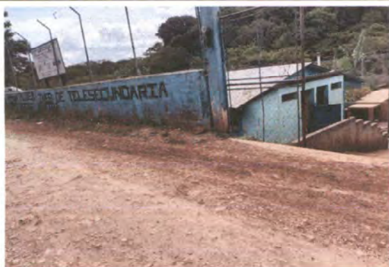
Foto 1: Completación de muro perimetral
