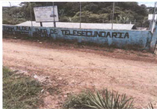
Foto 2: Completación de muro perimetral
