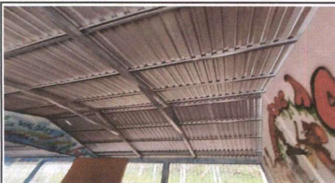
Foto 1: Sustitución de estructura de madera por estructura metálica (costaneras, tubos, tornillos)
