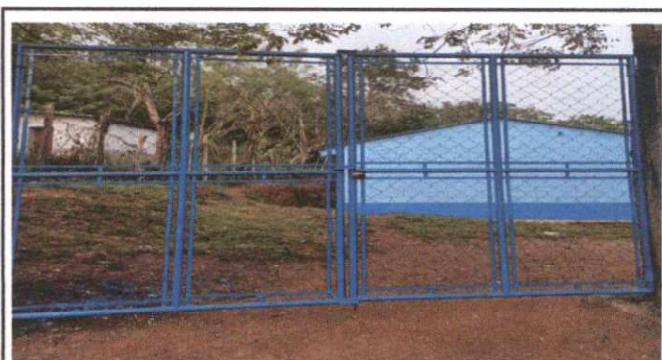
Foto 4: Sustitución de porton
