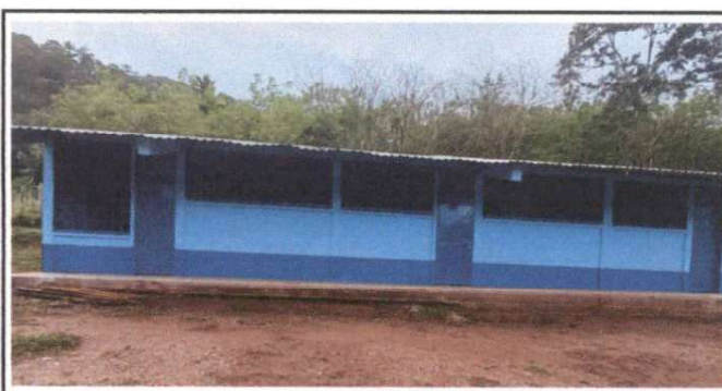
Foto 6: restauración de pintura
