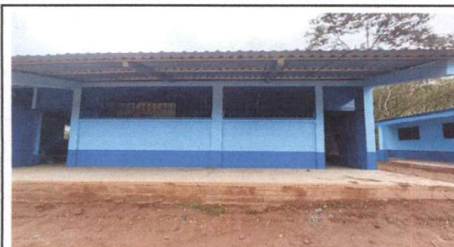
Foto 3: Aplicación de pintura de agua
