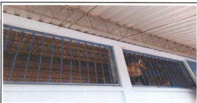
Foto 5: Sustitución de ventanales de vidrio por balcones de metal
