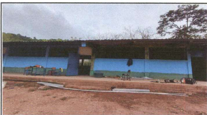
Foto 3: Aplicación de pintura de agua
