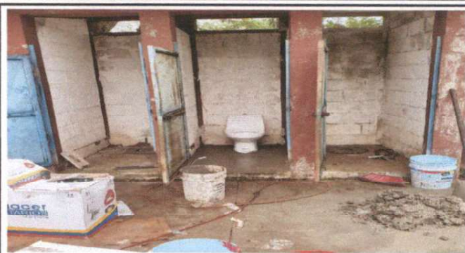
Foto 2: Sustitución de letrinas por sanitarios de porcelana
