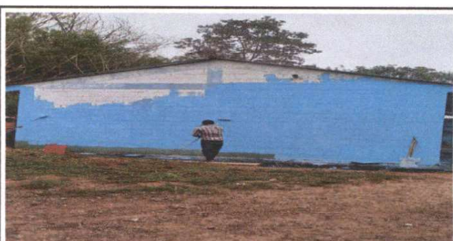
Foto 6: restauración de pintura
