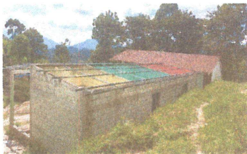
Foto 1: Sustrucción de Lámina y estructura
