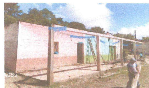
Foto 4: Sustrucción de Lámina y madera
