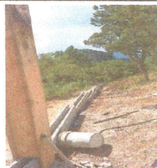
Foto 6: Segimiento de muro perimetral con circulación de malla
