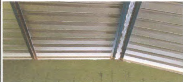
Foto 4: SUSTITUCION DE LAMINA EN DOS AULAS
