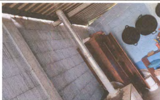
Foto 3: SUSTITUCION DE CHIMINEA EN MAL ESTADO
