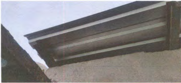
Foto 1: SUSTITUCION DE LAMINA DE BAÑO
