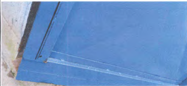
Foto 3: MANTENIMIENTO A PUERTAS DE BAÑO
