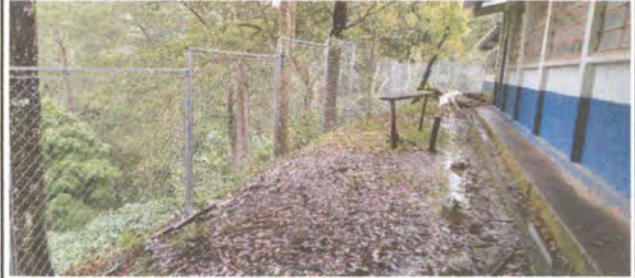
Foto 2: SUSTITUCION DE CERCO DE ALAMBRE POR MALLA Y TUBO
