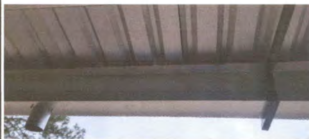
Foto 2: SUSTITUCION DE CANAL EN MAL ESTADO
