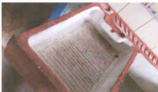
Foto 5: SUSTITUCION DE PILA
