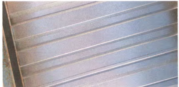
Foto 2: SUSTITUCION Y MEJORAMIENTO DE LAMINA DE BAÑO
