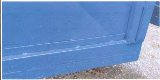
Foto 4: MANTENIMIENTO A PUERTAS DE BAÑO
