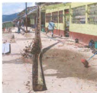
Foto 2: SUSTITUCION DE CANAL EN MAL ESTADO
