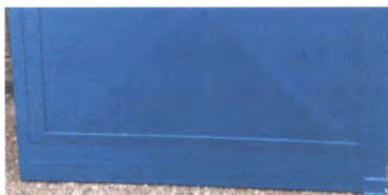
Foto 4: MANTENIMIENTO A PUERTAS DE BAÑO
