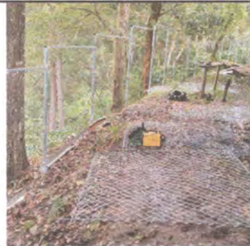
Foto 2: SUSTITUCION DE CERCO DE ALAMBRE POR MALLA Y TUBO
