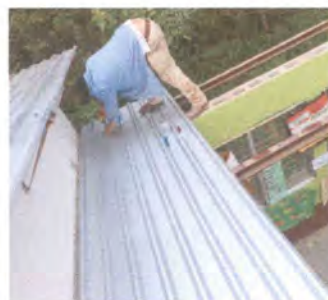
Foto 6: SUSTITUCION DE LAMINA EN DOS AULAS
