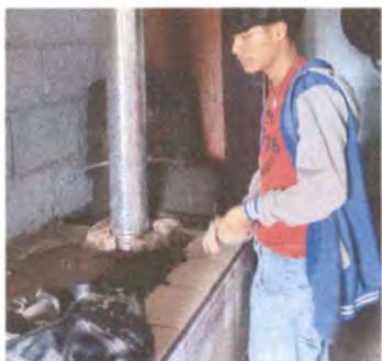
Foto 3: SUSTITUCION DE CHIMINEA EN MAL ESTADO
