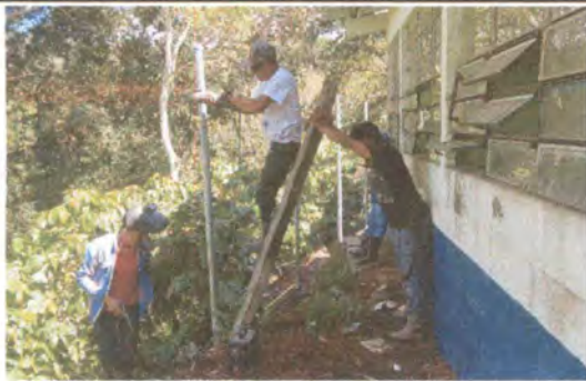
Foto 3: SUSTITUCION DE CERCO DE ALAMBRE POR MALLA Y TUBO
