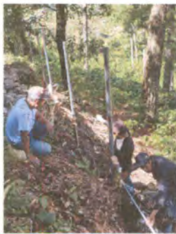
Foto1: SUSTITUCION DE CERCO DE ALAMBRE POR MALLA Y TUBO
