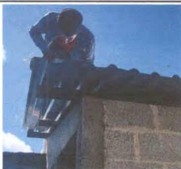
Foto1: SUSTITUCION DE LAMINA DE BAÑO
