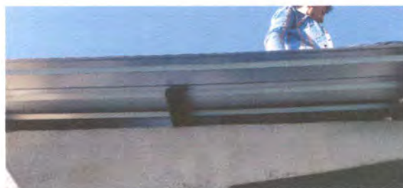
Foto 2: SUSTITUCION Y MEJORAMIENTO DE LAMINA DE BAÑO
