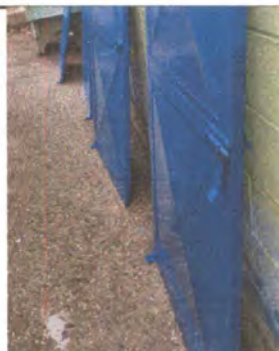
Foto 3: MANTENIMIENTO A PUERTAS DE BAÑO
