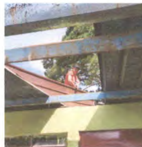
Foto 4: SUSTITUCION DE LAMINA EN DOS AULAS
