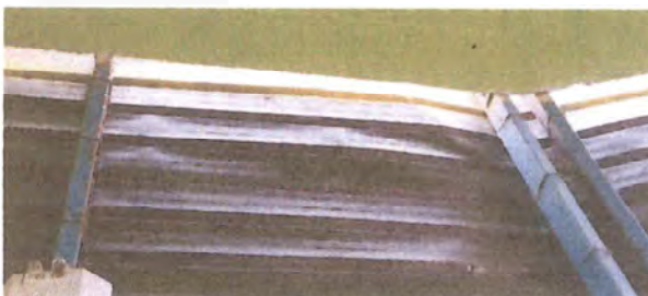
Foto 4: SUSTITUCION DE LAMINA DE DOS AULAS
