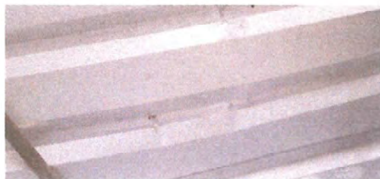
Foto 2: SUSTITUCION DE LAMINA DE BAÑO EN MALESTADO
