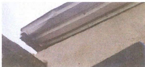
Foto 1: SUSTITUCION DE LAMINA DE BAÑO EN MALESTADO
