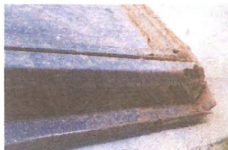
Foto 4: MANTENIMIENTO A PUERTAS DE BAÑO
