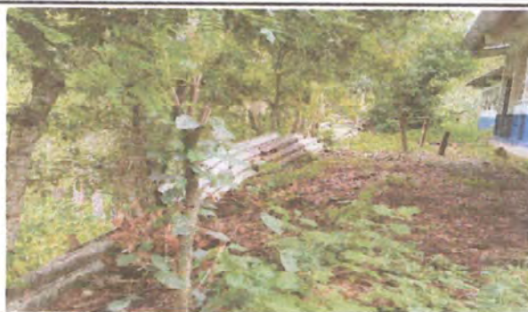
Foto 2: SUSTITUCION DE CERCO DE ALAMBRE POR MALLA
