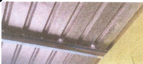
Foto 5: SUSTITUCION DE LAMINA DE DOS AULAS
