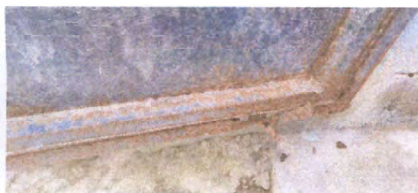
Foto 3: MANTENIMIENTO A PUERTAS DE BAÑO
