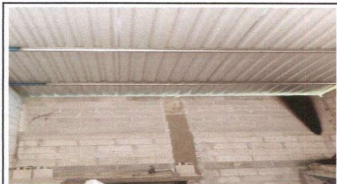
Foto 3: Cocina (Cambio de techo)
