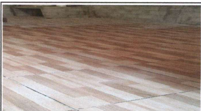
Foto 4: Cocina (Instalación de piso cerámico).
