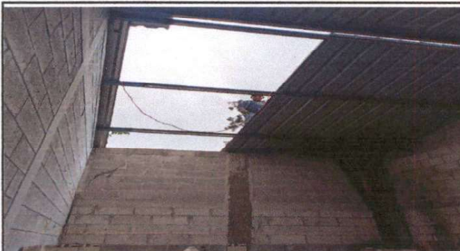
Foto 3: Cocina (Cambio de techo)
