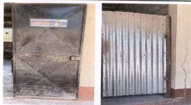
Foto 4: Mantenimiento de estructura y pintura de 5 puertas y sustitución de puerta de lamina a puerta de metal legitimo
