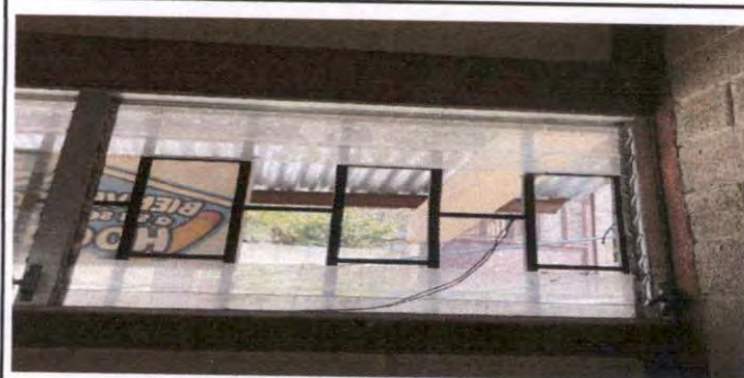
Foto 6: colocación de 8 paletas de vidrio
