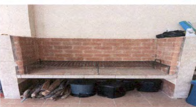
Foto 16: instalación de chimenea
