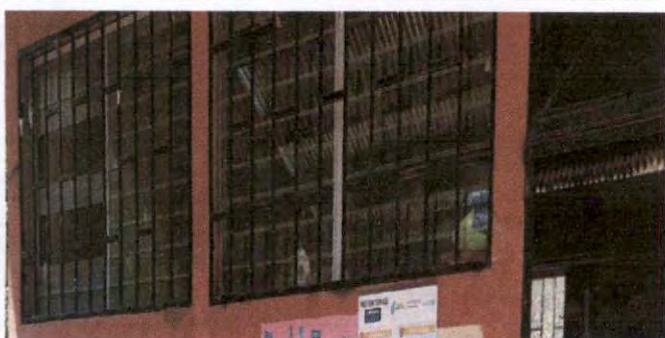
Foto 11: pintura a 4 balcones de baranda
