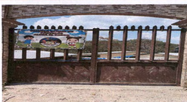
Foto 14: mantenimiento a porton de metal
