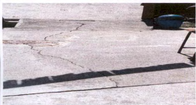
Foto 15 : Reparación de planchas de concreto de patio
