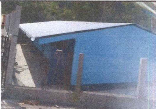
Foto 3: Sustitución de lámina.
