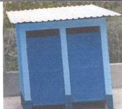
Foto 8: Mantenimiento y pintura de puertas.
