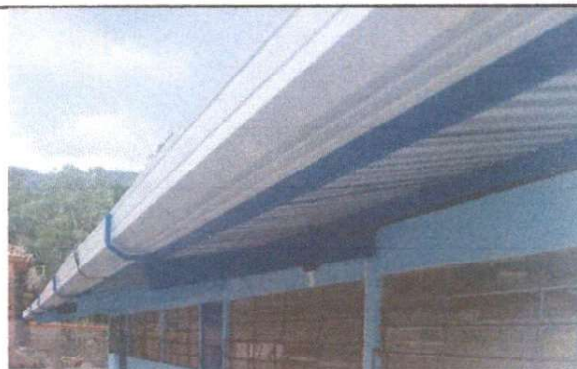
Foto 10: Instalación de canales.
