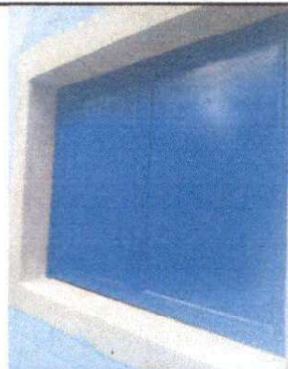
Foto 4: Instalación de ventana de metal.
