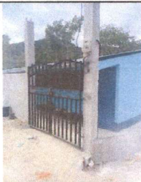
Foto 7: Reforzamiento de bases y sustitución de portón.
