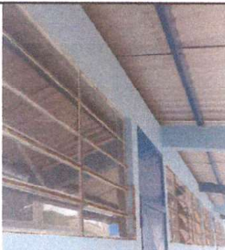
Foto 5: Sustitución de vidrios en mal estado.
