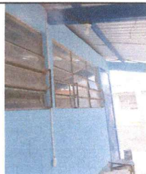
Foto 6: Reparación del sistema eléctrico.
