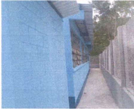
Foto 1: Reparación del muro perimetral.
