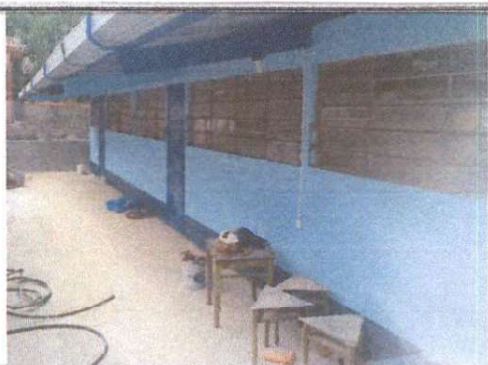
Foto 11: Pintura de muros exteriores.
