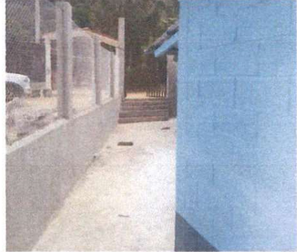
Foto 2: Reparación de losa de patio.
