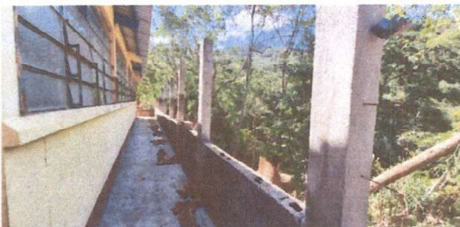
Foto 1: Reparación del muro perimetral.
