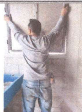
Foto 4: Instalación de ventana de metal.
