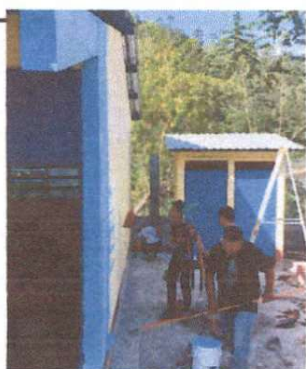
Foto 11: Pintura de muros exteriores.
