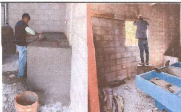
Foto 9: Sustitución del área de cocina.
