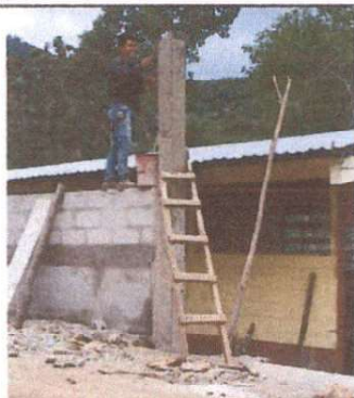
Foto 7: Reforzamiento de bases y sustitución de portón.
