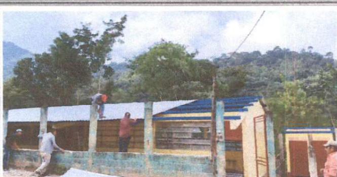
Foto 3: Sustitución de lámina.
