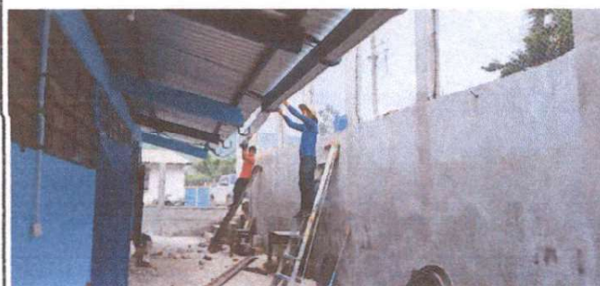
Foto 10: Instalación de canales.
