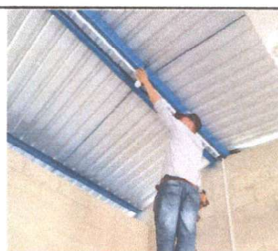
Foto 6: Reparación del sistema eléctrico.
