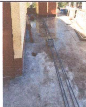
Foto 2: Reparación de losa de patio.
