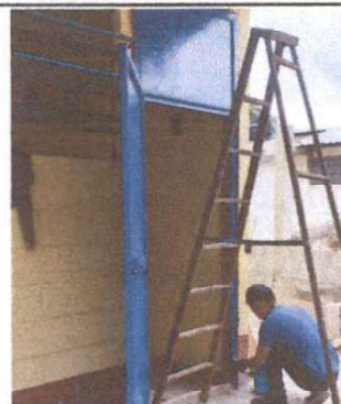
Foto 8: Mantenimiento y pintura de puertas.
