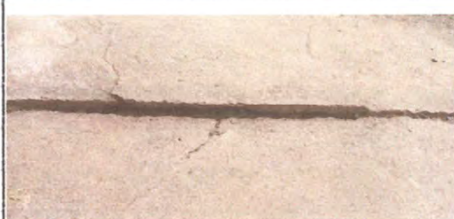
Foto 2: Reparación de losa de patio.
