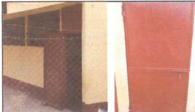
Foto 8: Mantenimiento y pintura de puertas.
