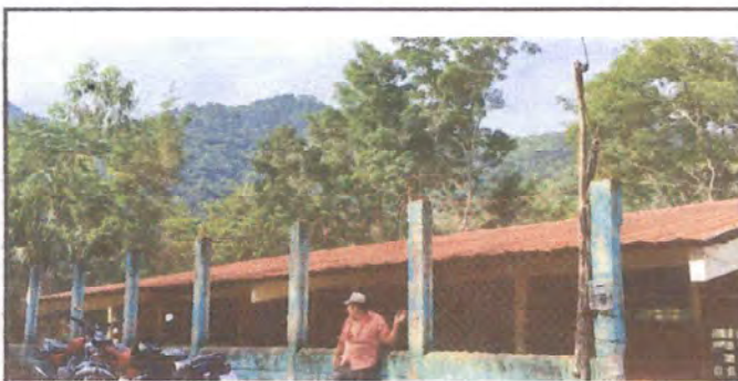
Foto 3: Sustitución de lámina.
