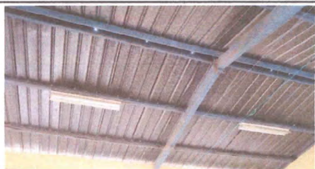
Foto 6: Reparación del sistema eléctrico.
