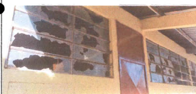
Foto 5: Sustitución de vidrios en mal estado.
