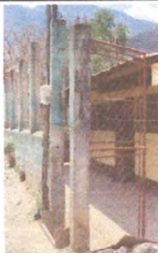
Foto 7: Reforzamiento de bases y sustitución de portón.
