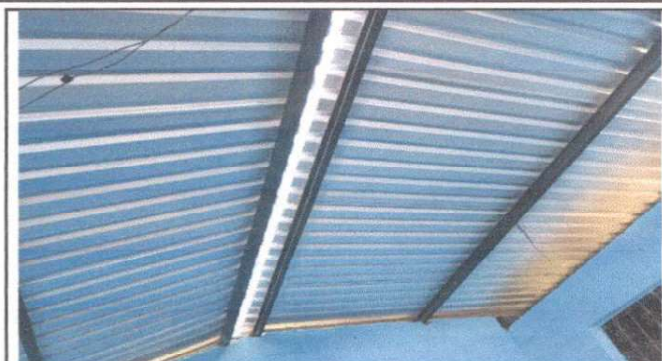
Foto1: Sustitución de lámina.
