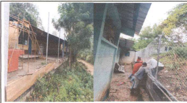
Foto 4: Reparación del muro perimetral.
