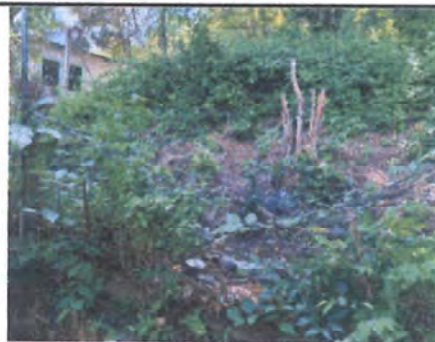
Foto 4: Reparación del muro perimetral.
