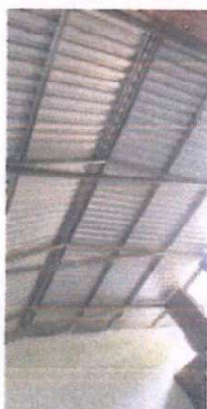
Foto 3: Sustitución de madera por metal
