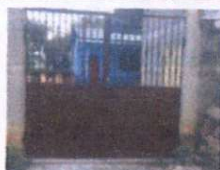
Fabricación e instalación de portón de ingreso Firma y sello del Presidente de la OPF
