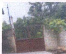
fabricacion e instalacion de porton de ingreso
