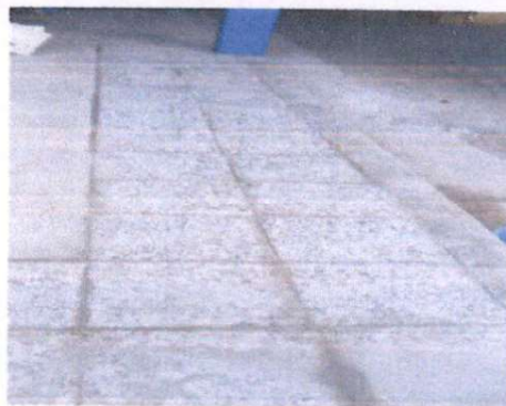
Foto 2: Reparacion de piso
