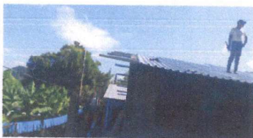
Foto 1: Sustitucion de lamina en aula.
