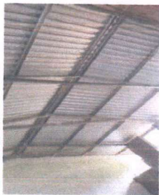
Foto 3: Sustitucion de madera por metal
