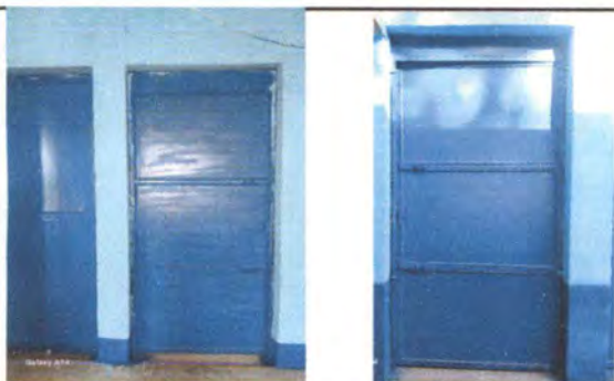
Foto 3: Mantenimiento a puertas metálicas.
