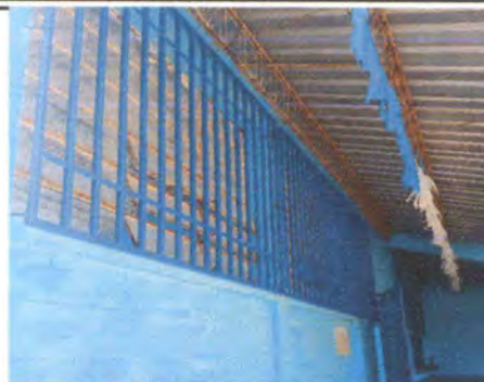
Foto 2: Instalación de balcones metálicos.
