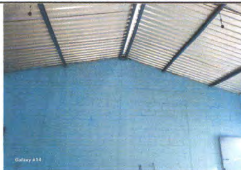
Foto1: Sustitución de lámina por lámina canalada.
