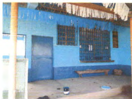
Foto 6: Instalación de balcones metálicos.
