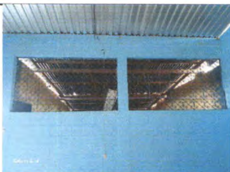
Foto 5: Mantenimiento de balcones metálicos.
