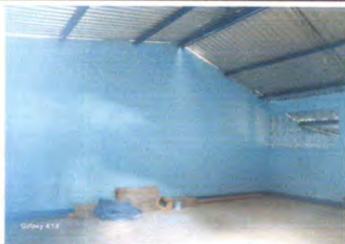
Foto 3: Pintura de interior de aulas.
