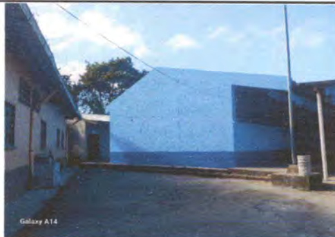
Foto 4: Pintura de exterior de aulas.
