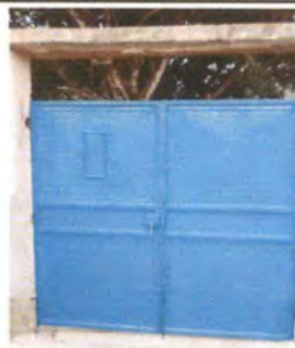
Foto 4: Sustitución de portón metálico.
