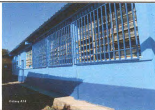
Foto 1: Instalación de balcones metálicos.
