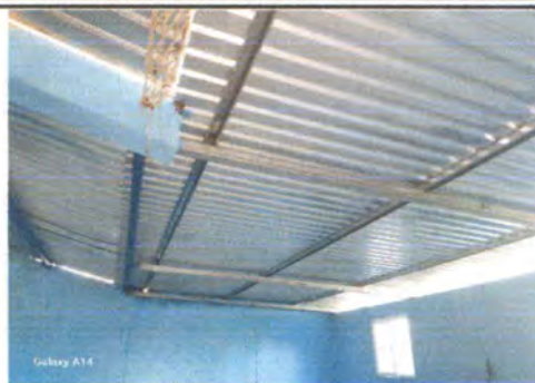
Foto 2: Sustitución de estructura de madera por estructura metálica.
