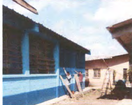
Foto 1: Instalación de balcones metálicos.
