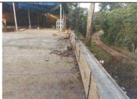
Foto 6: Reparación de muro perimetral y malla galvanizada.
