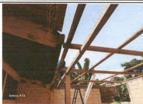
Foto 2: Sustrucción de estructura de madera por estructura metálica.
