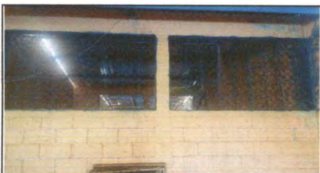
Foto 5: Mantenimiento de balcones metálicos.
