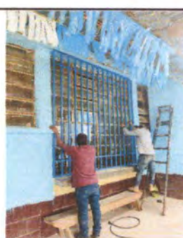
Foto 6: Instalación de balcones metálicos.
