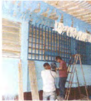
Foto 2: Instalación de balcones metálicos.
