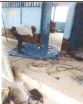
Foto 3: Mantenimiento a puertas metálicas.
