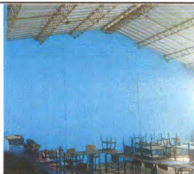
Foto 3: Pintura de interior de aulas.
