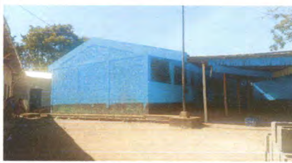
Foto 4: Pintura de exterior de aulas.
