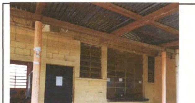
Foto 6: Instalación de balcones metálicos.
