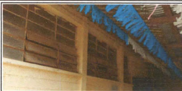
Foto 2: Instalación de balcones.
