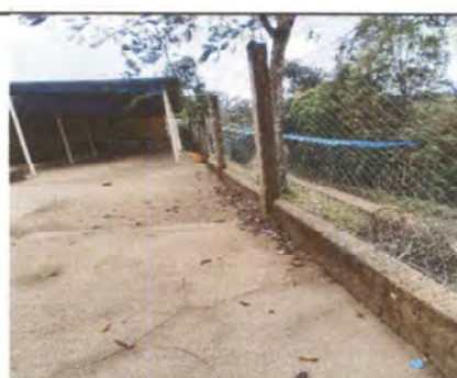
Foto 6: Reparación de muro perimetral y malla galvanizada.
