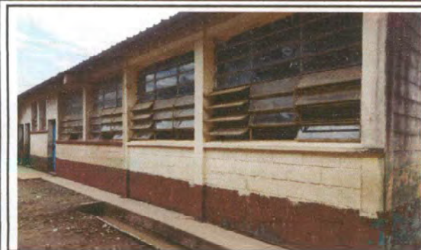
Foto 1: Instalación de balcones.
