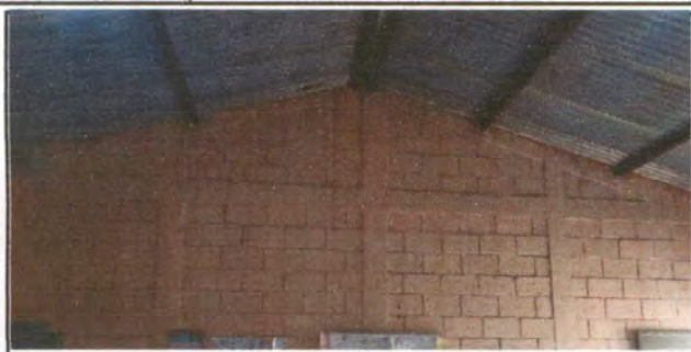
Foto 1: Sustitución de lámina por lámina canalada.
