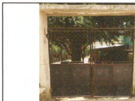
Foto 4: Sustitución de portón metálico.
