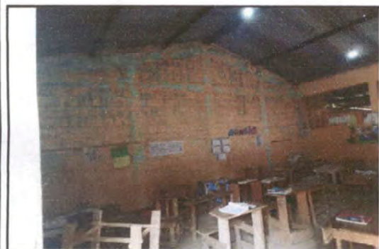
Foto 3: Pintura de interior de aulas.
