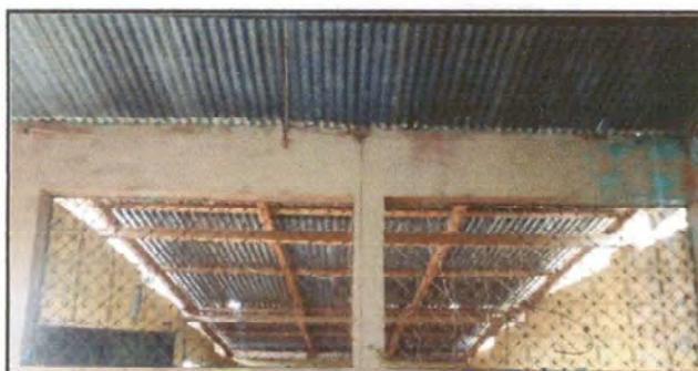
Foto 5: Mantenimiento de balcones metálicos.
