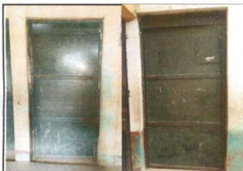
Foto 3: Mantenimiento a puertas metálicas.
