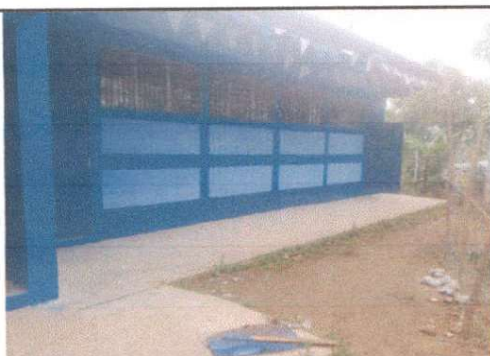
Foto 5: Pintura de exterior de aulas
