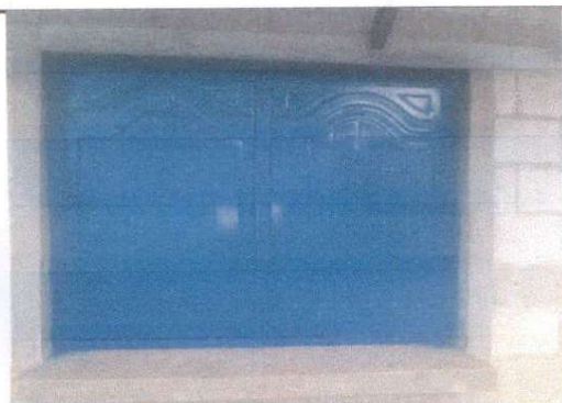
Foto 3: Mantenimiento de ventanas (lijado y pintado)
