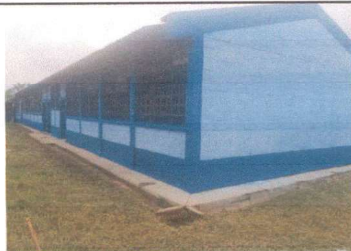
Foto 4: Colocación de balcones de metal.
