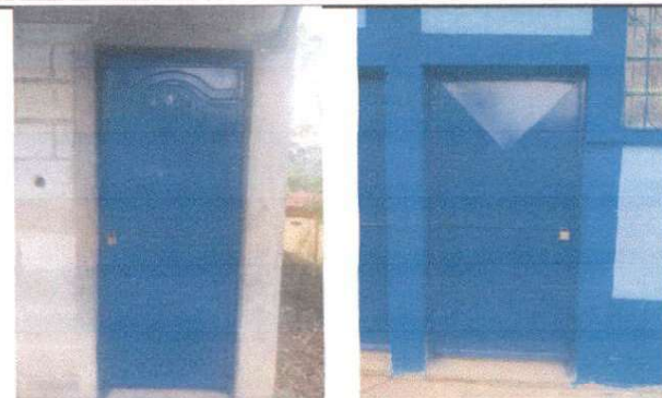
Foto 2: Mantenimiento de puertas (lijado y pintado)
