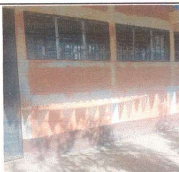
Foto 5: Pintura de exterior de aulas
