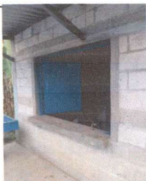
Foto 3: Mantenimiento de ventanas (lijado y pintado)
