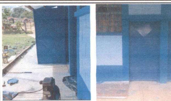
Foto 2: Mantenimiento de puertas (lijado y pintado)
