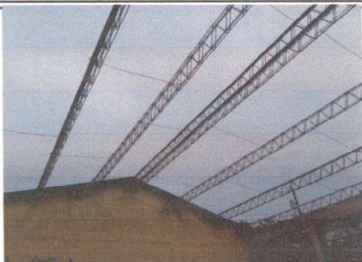
Foto1: Sustitución de techo y pintura de estructura metálica
