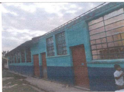
Foto 4: Colocación de balcones de metal (limpieza del área)
