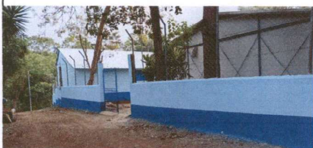
Foto 5: REPARACIÓN DEL MURO PERIMETRAL
