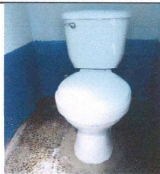
Foto 4: SUSTITUCIÓN DE SANITARIOS
