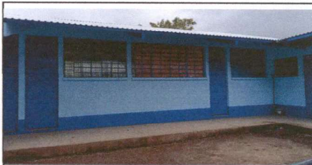
Foto 6: PINTURA DE MUROS INTERNOS Y EXTERNOS.
