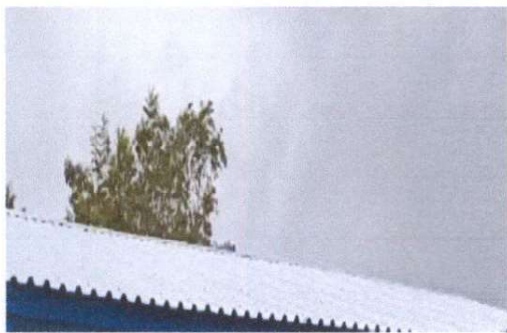
Foto 1: SUSTITUCIÓN DE LÁMINA EN MAL ESTADO
