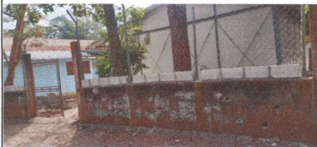
Foto 5: REPARACIÓN DEL MURO PERIMETRAL
