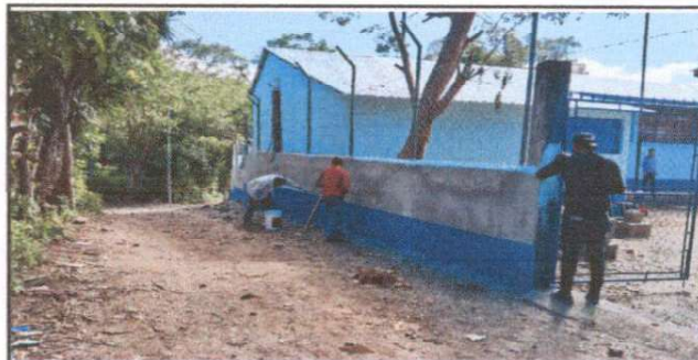
Foto 6: PINTURA DE MUROS INTERNOS Y EXTERNOS.
