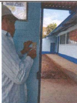
Foto 3: REPARACIÓN DEL SISTEMA ELÉCTRICO
