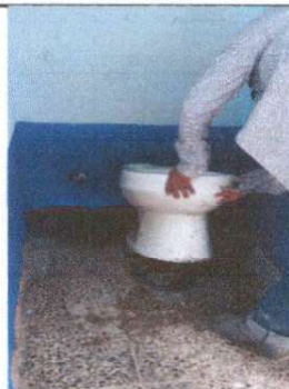
Foto 4: SUSTITUCIÓN DE SANITARIOS
