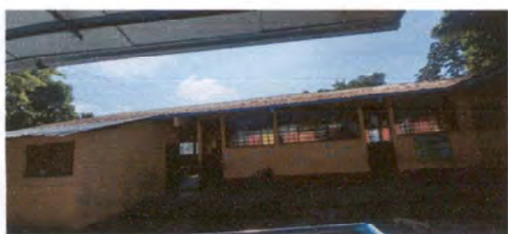
Foto 1: Cubierta de lámina
