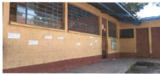
Foto 6: PINTURA DE MUROS INTERIOR Y EXTERIOR (PINTURA DE PAREDES)
