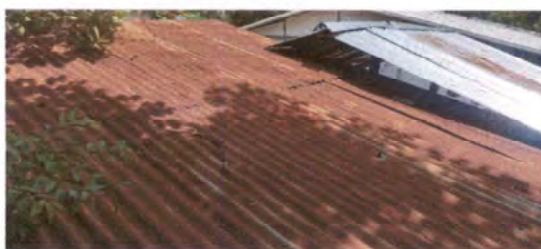
Foto 8 : REPARACIÓN O SUSTITUCIÓN DE ÁREA DE COCINA
