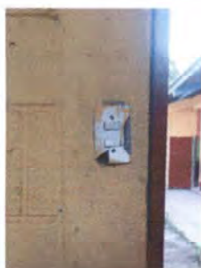
Foto 7: REPARACIÓN DE SISTEMA ELÉCTRICO
