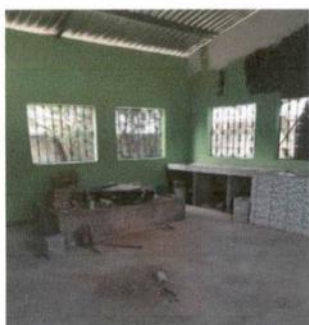
Foto 3: Remodelación de pila de la cocina
