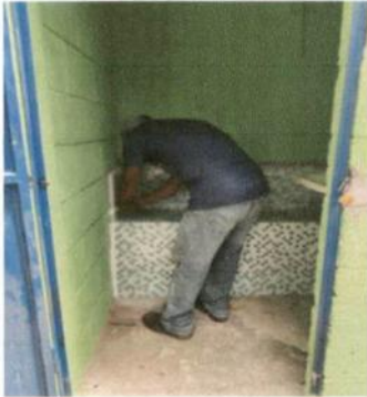
Foto1: Reparación de migitorios.
