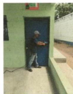
Foto 4: Reparación de puerta de aula.
