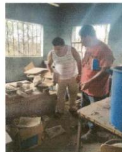
Foto 2: Trabajos de polleton
