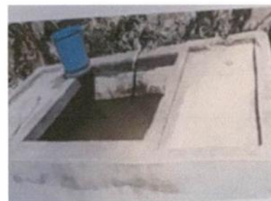
Foto 6: Mejoramiento de pila del patio.
