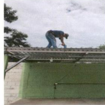
Foto 2: Instalación de techo de escenario.
