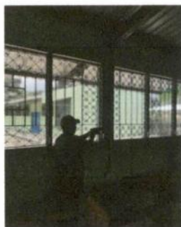
Foto 5: Colocación de persiana.
