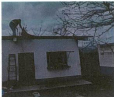
Foto1: Desmontaje de techo de cocina.
