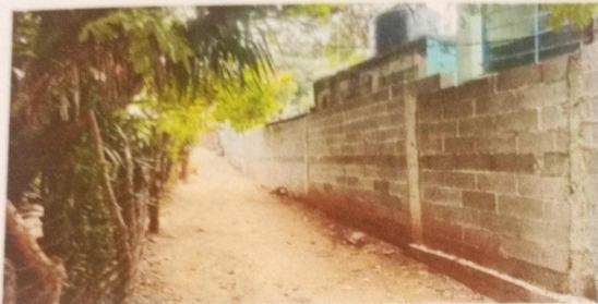
Reparación de muro perimetral
