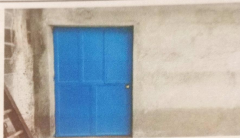
Cambio de puerta de maya por puerta de metal
