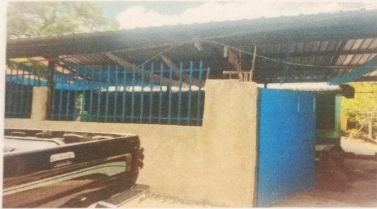
Cambio de portón de maya por portón de metal
