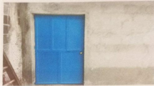
Cambio de puerta de maya por puerta de metal
