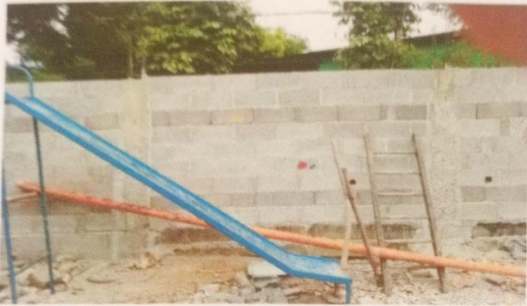
Reparación de muro perimetral
