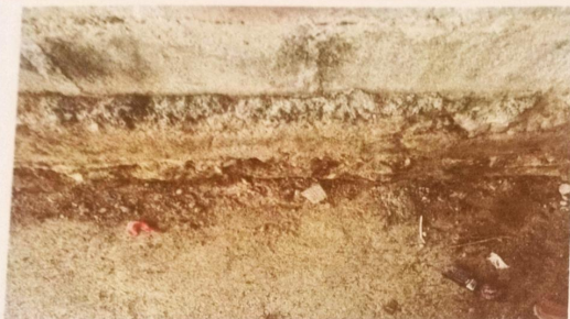
Reparación de muro perimetral
