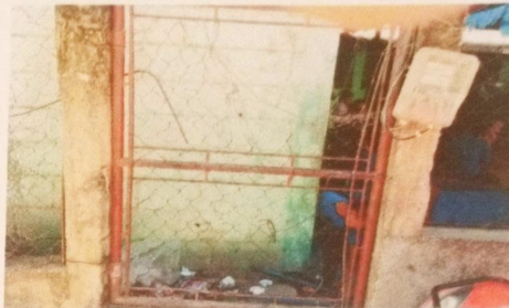
Cambio de puerta de maya por puerta de metal
