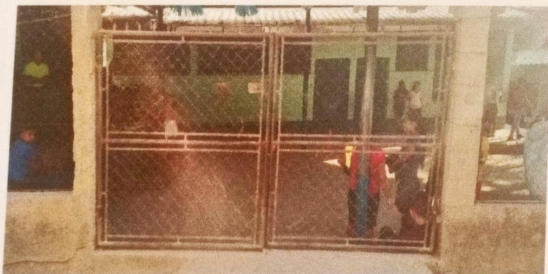
Cambio de portón de maya por portón de metal
