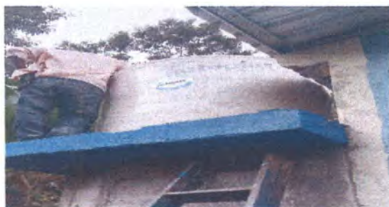
Foto 15: Instalación de sistema de depósito de agua y sus accesorios.
