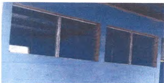
Foto 11: Mantenimiento a barandas de metal.
