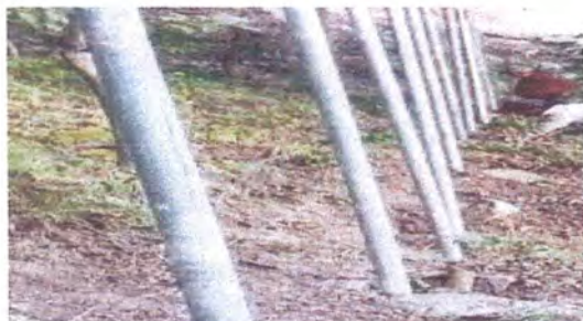
Foto 13: Reparación de muropérimetro de malla con tubo HG y malla.
