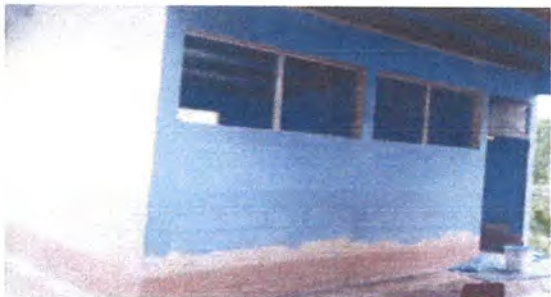
Foto 7 : Pintura de muros interiores y exteriores.
