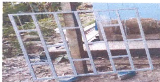
Foto 12: Instalación de barandas de metal.
