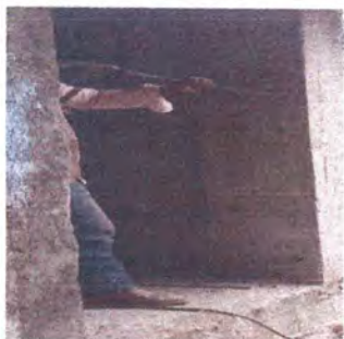
Foto 9: Instalación de puertas de servicios sanitarios.
