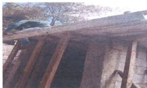
Foto 7: Reparación de muro de baño.
