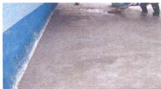
Foto 16: Reparación de piso de concreto.
