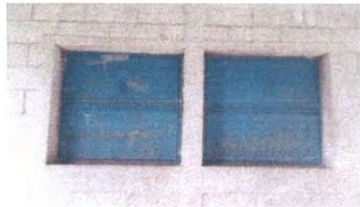
Foto 10: Mantenimiento a estructura de metal de ventana
