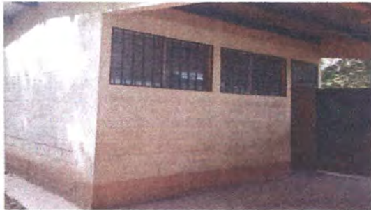
Foto7 : Pintura en muros interiores y exteriores.
