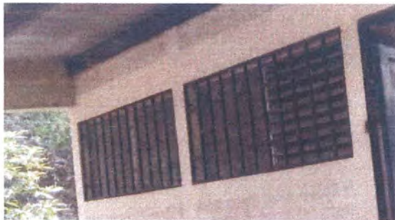
Foto 11: Mantenimiento a barandas de metal.
