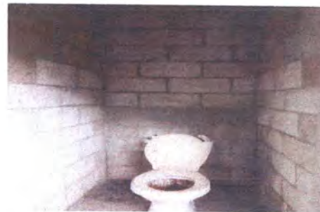
Foto 7: Reparación de muro de baño.
