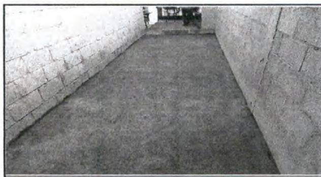
Foto 6: Losa de patio
