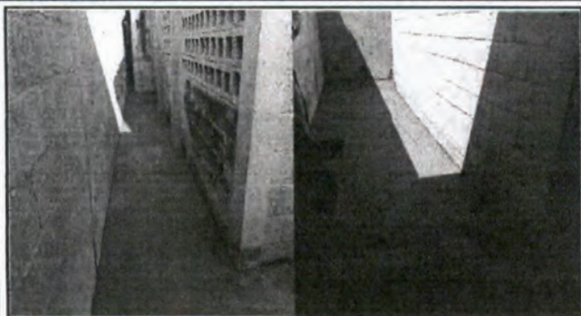
Foto 7: Losa de patio (atrás del aula 3)
