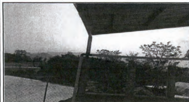
Foto 9: canales y bajadas de aguas pluvial
