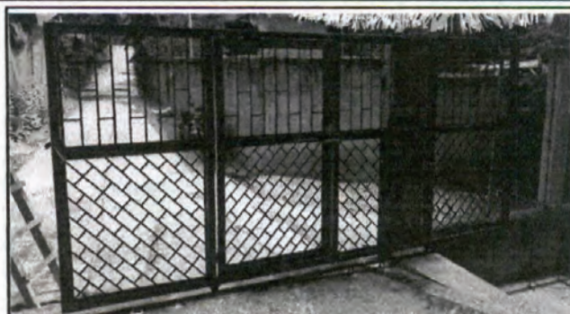
Foto 8: mantenimiento de Portón
