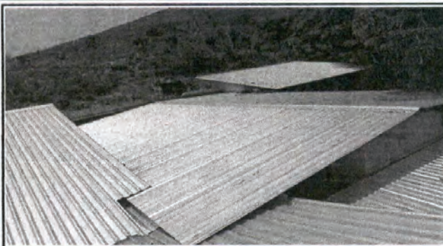
foto 2: Aula 1 cambio de techo
