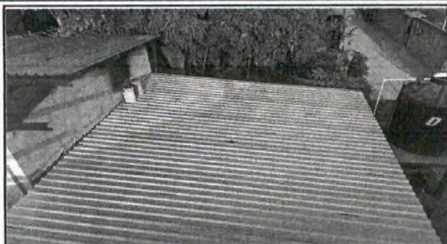
Foto 1: Cocina Cambio de techo
