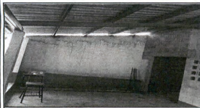
foto 5: Escenario Cambio de techo
