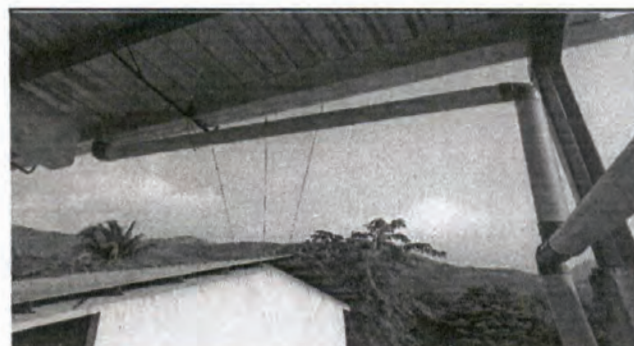
Foto 10: canales y bajadas de aguas pluviales
