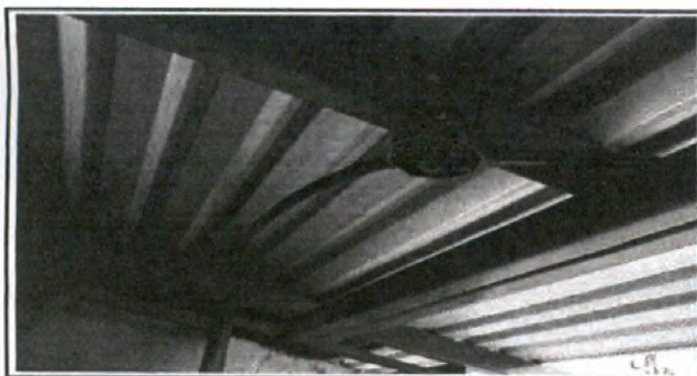
Foto 11: reparación de Sistema Eléctrico
