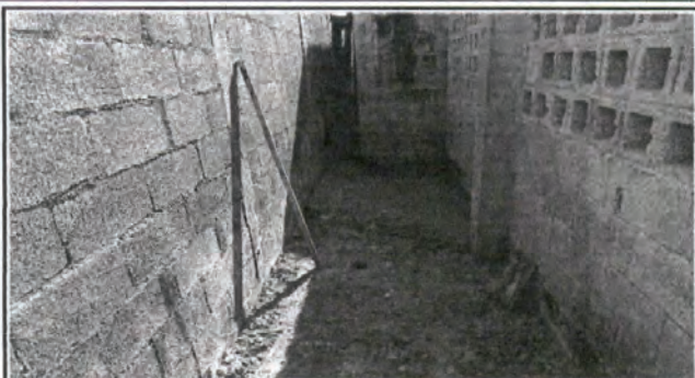
Foto 7: Losa de patio (atrás del aula 3)
