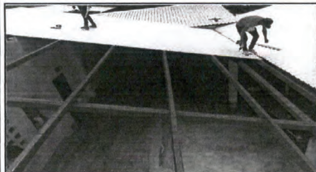
foto 3: Aula 2 cambio de techo
