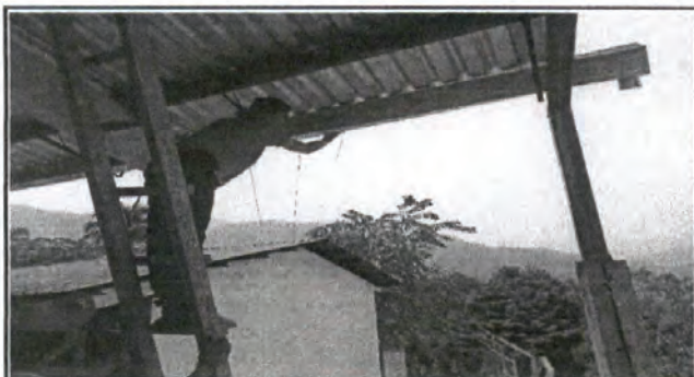
Foto 9: canales y bajadas de aguas pluvial
