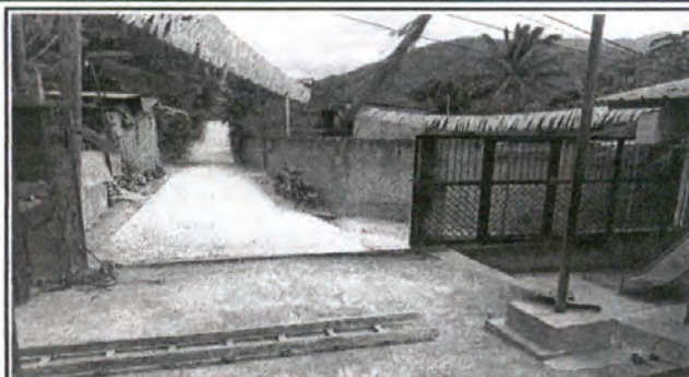
Foto 8: mantenimiento de Portón
