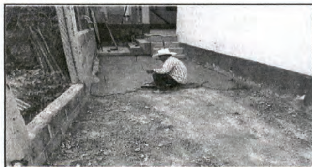
Foto 6: Losa de patio
