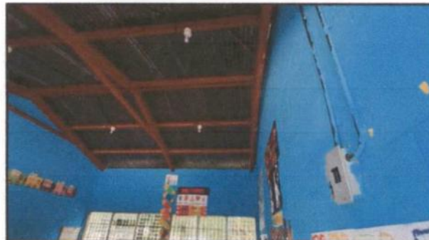
Reparación e instalación de sistema electrónico
