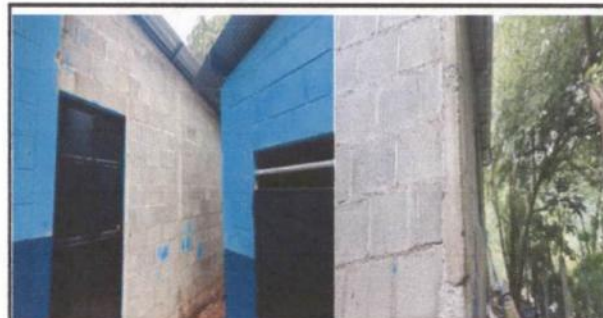
levantado de pared, aplicación de torta de semento, sustitución de lamina acanalada por troquelada, colocación de puerta y 2 ventanas
