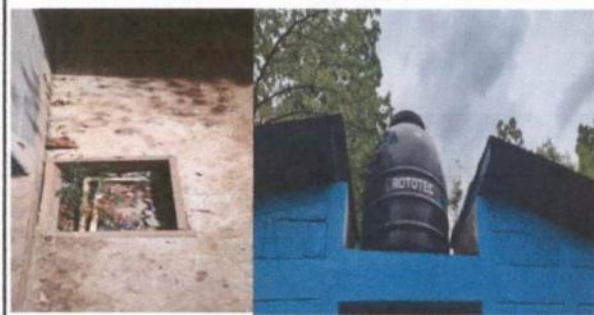
Reparación de tubería y colocación de cisterna
