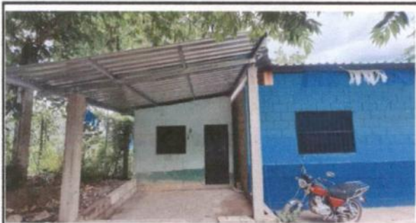
Aplicación de torta de cenaneto y sustitución de lamina canalada a troquelada y sustitución de puerta.
