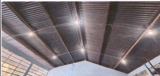
Foto1: Sustitución de lamparas
