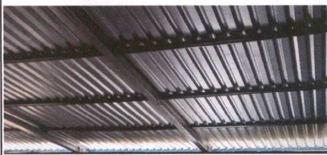
Foto 2: Instalación de techo para cocina
