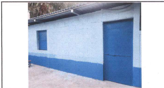
Foto 6: Ampliación de cocina
