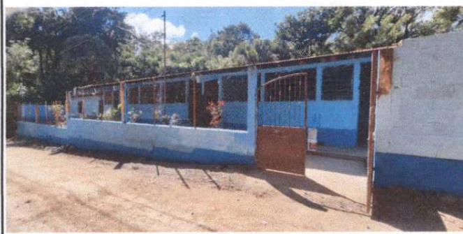
Foto 3: Pintura en muro exterior e interior
