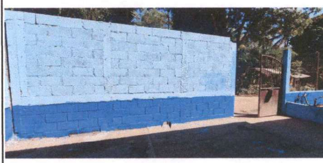
Foto 4: Reparación de muro perimetral
