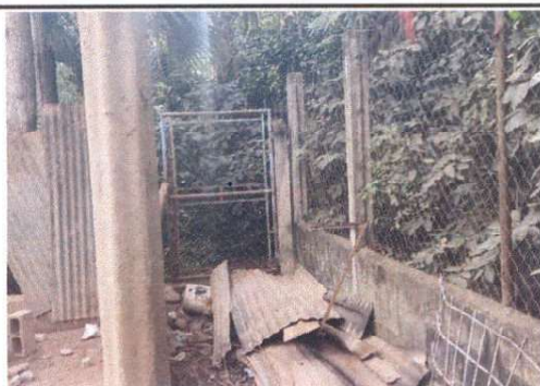
Foto 5: Desinstalación de puerta
