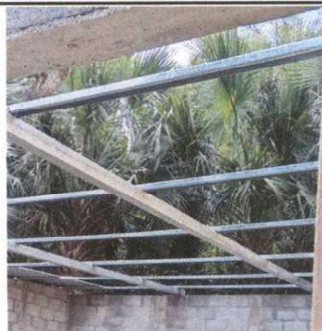
Foto 2: Instalación de techo para cocina
