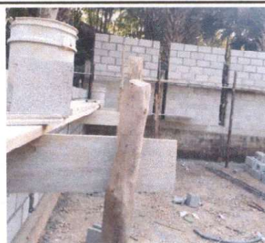
Foto 6: Ampliación de cocina
