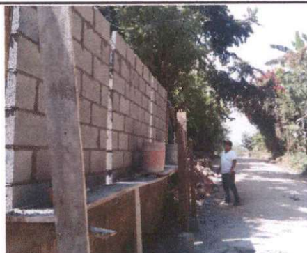
Foto 4: Reparación de muro perimetral
