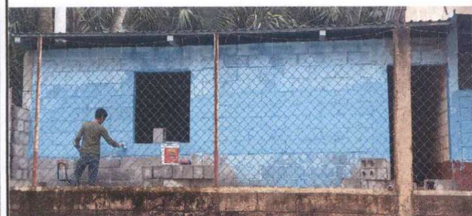
Foto 3: Pintura en muro exterior e interior
