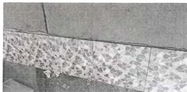
Foto2: COLOCACIÓN DE CERAMICA EN EL CORREDOR
