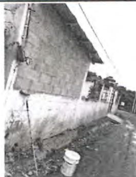
Foto 8: Reparación del muro perimetral
