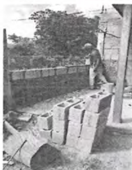
Foto 3: REPARACIÓN DE MURO
