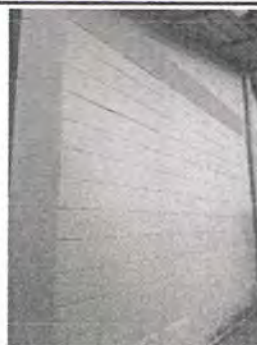
Foto 6: PINTURA EN EXTERIORES
