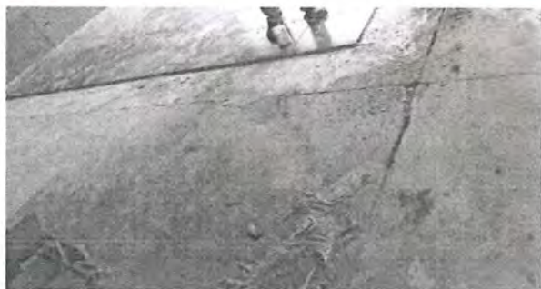
Foto1: COLOCACIÓN DE CERAMICA EN AULAS
