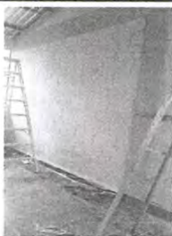
Foto 5: PINTURA EN INTERIORES DE AULAS
