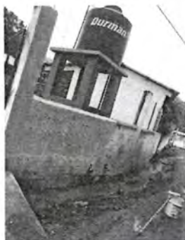
Foto 9: PINTURA DEL MURO PERIMETRAL
