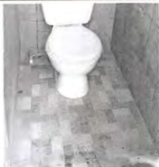
Foto 7: Reparación de baños
