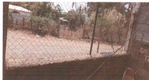
Foto 10: SUSTITUCIÓN DE MAYA POR BLOCK
