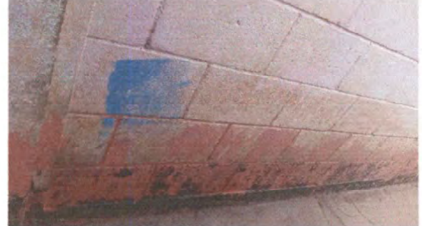
Foto 6: DAÑOS EN LA PINTURA DEL EXTERIOR DE LAS AULAS
