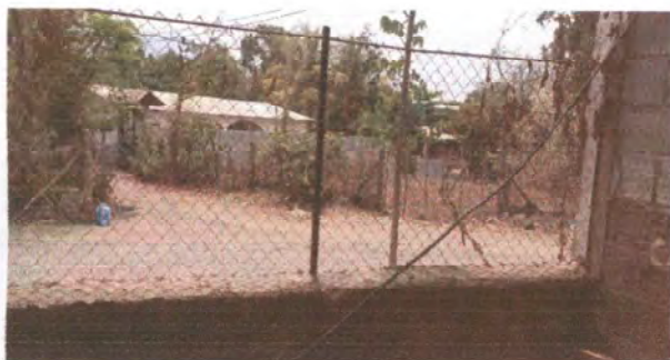
Foto 9: SUSTITUCIÓN DE MAYA POR BLOCK
