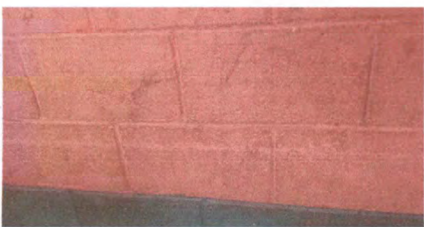
Foto 5: DAÑOS EN LA PINTURA DEL INTERIOR DE AULAS
