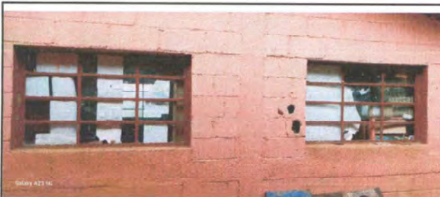
Foto 5: Instalación de balcones metalicos.
