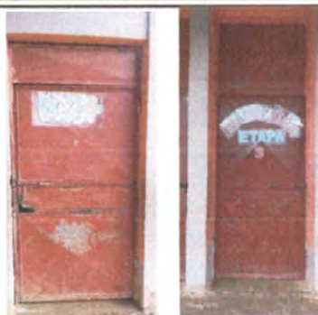
Foto 2: Mantenimiento de puertas (cepillado, lijado y pintado)
