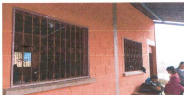
Foto 4: Mantenimiento de ventanales (lijado y pintado).
