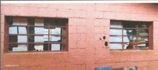
Foto 5: Instalación de balcones metalicos.
