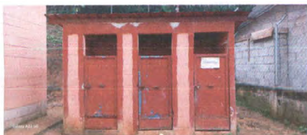
Foto 3: Mantenimiento de puertas de sanitarios
