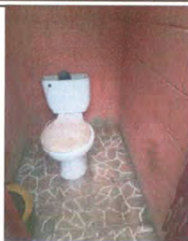
Foto 1: Sustrución de baños y accesorios.
