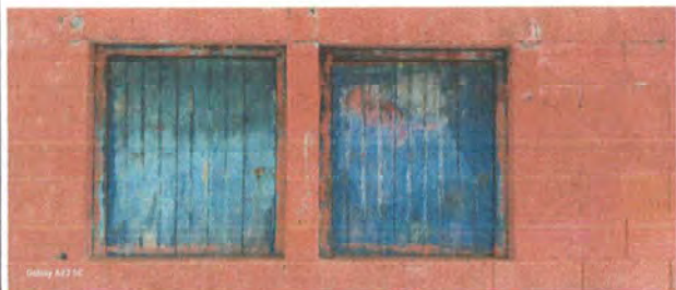
Foto 1: Sustrucción de ventanas de madera por ventanas metalicas
