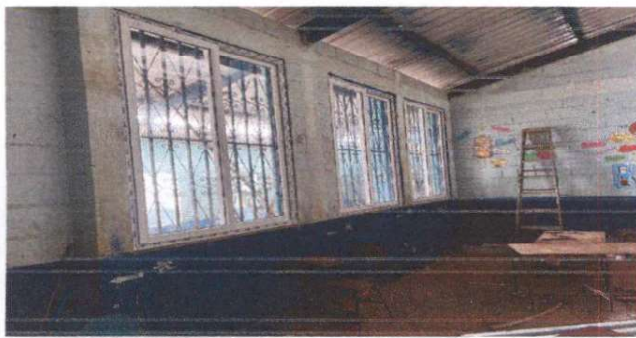
Foto 3: Sustitución de ventanas por corelizas
