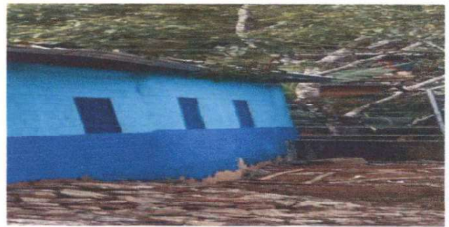
Foto 2: Reparación y continuación de muro perimetral
