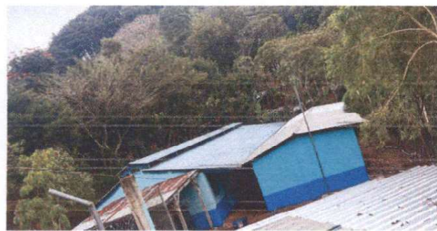
Foto 5: Pintura de muros exterior e interior
