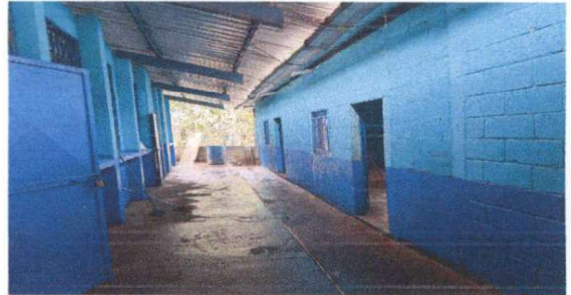
Foto 4: Reparación y continuación de losa
