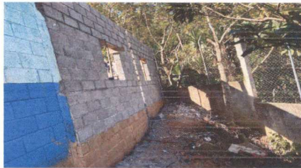
Foto 2: Reparación y continuación de muro perimetral
