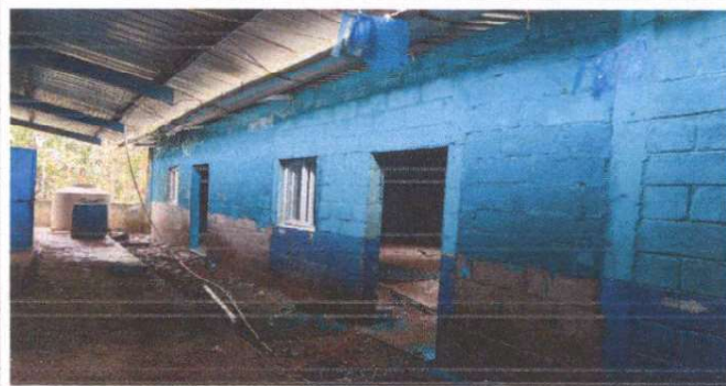
Foto 4: Reparación y continuación de losa
