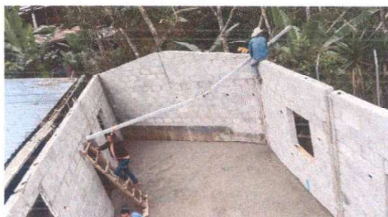
Foto 6: Ampliación y sustitución de cubierta de lámina
