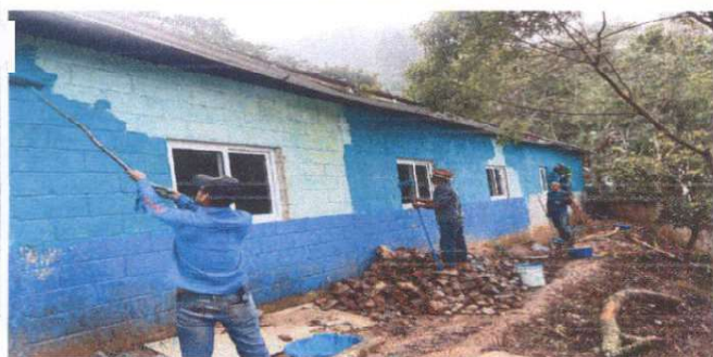
Foto 5: Pintura de muros exterior e interior
