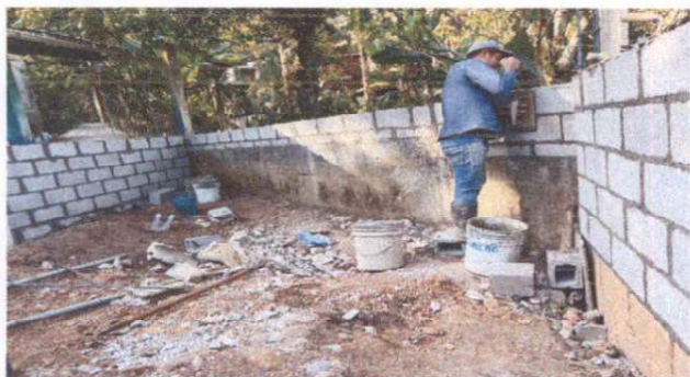
Foto 1: Continuación de muro de block
