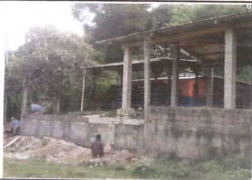
Foto 3: colocación de techo.
