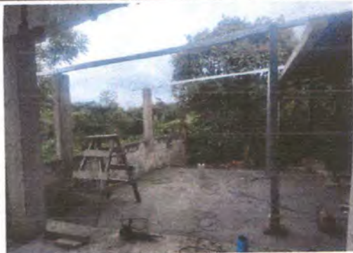
Foto1: Instalación de Estructura para techo.
