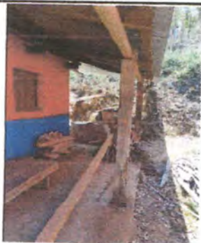
Foto 5: Mejoramiento de columnas de la cocina.
