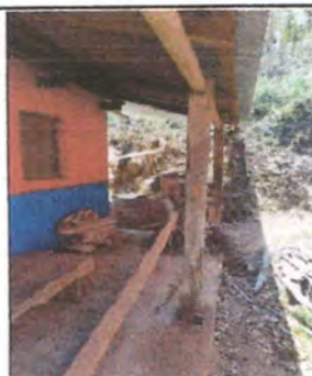
Foto 5: Mejoramiento de columnas de la cocina.
