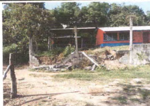
Foto 4: Reparación de muro perimetral.
