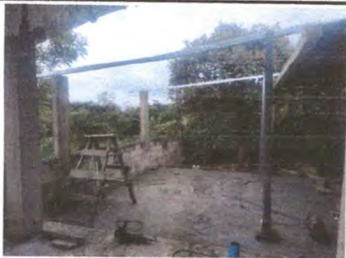
Foto 1: Instalación de Estructura para techo.
