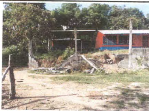
Foto 4: Reparación de muro perimetral.
