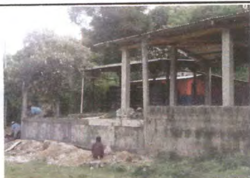
Foto 3: colocación de techo.
